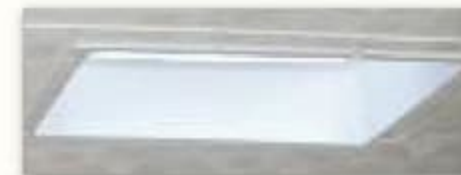
Puits de lumière dans la cuisine
