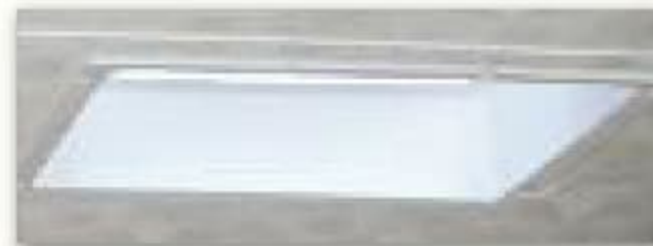
Puits de lumière dans la cuisine
